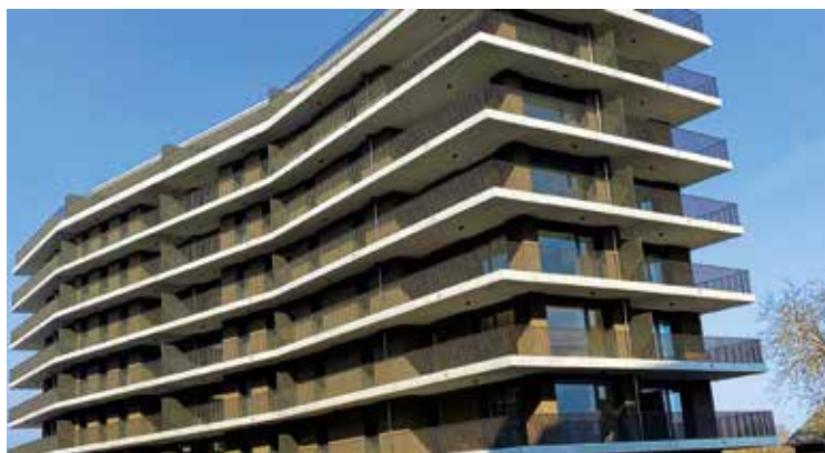
Immeuble dans le nouveau quartier de Saint-Mathieu (Bernex) réalisé en Total Service Contractor.
