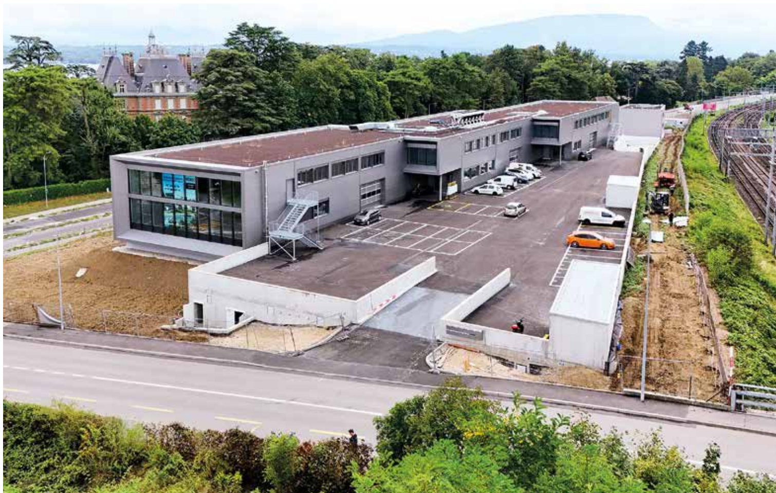
Le bâtiment industriel et artisanal les Fayards à Versoix illustre ce savoir-faire de Pillet SA.
