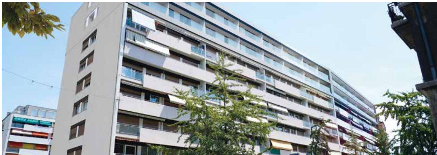
Travaux de surélévation effectués sur un immeuble à la rue Caroline (Carouge) par Pillet SA.
