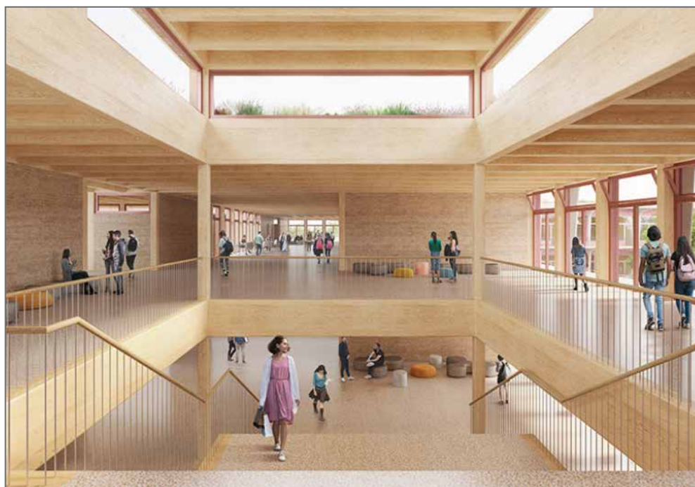
Toute la structure du futur groupe scolaire des Cherpines/Confignon est en bois, alors que celle des coursives en façade est en maçonnerie.
