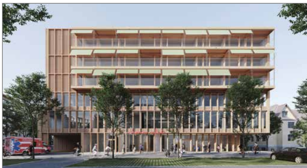
Le nouvel hôpital des enfants des HUG sera quasi intégralement construit en bois (noyau de la structure en béton armé).
