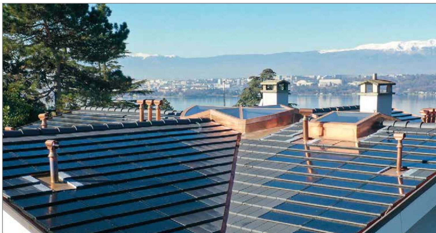
Les panneaux s'intègrent facilement à la toiture.
