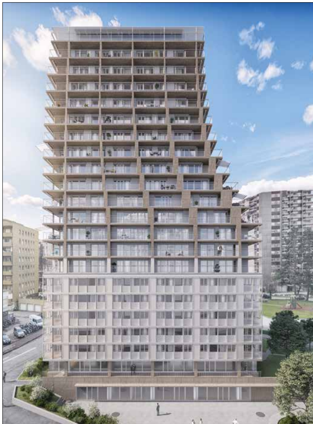
Le nouveau foyer de plus de 300 habitants.
