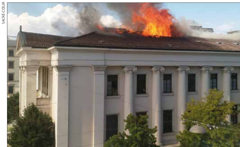
Le 19 juillet 2018, un incendie détruit l'intérieur de l'église.
