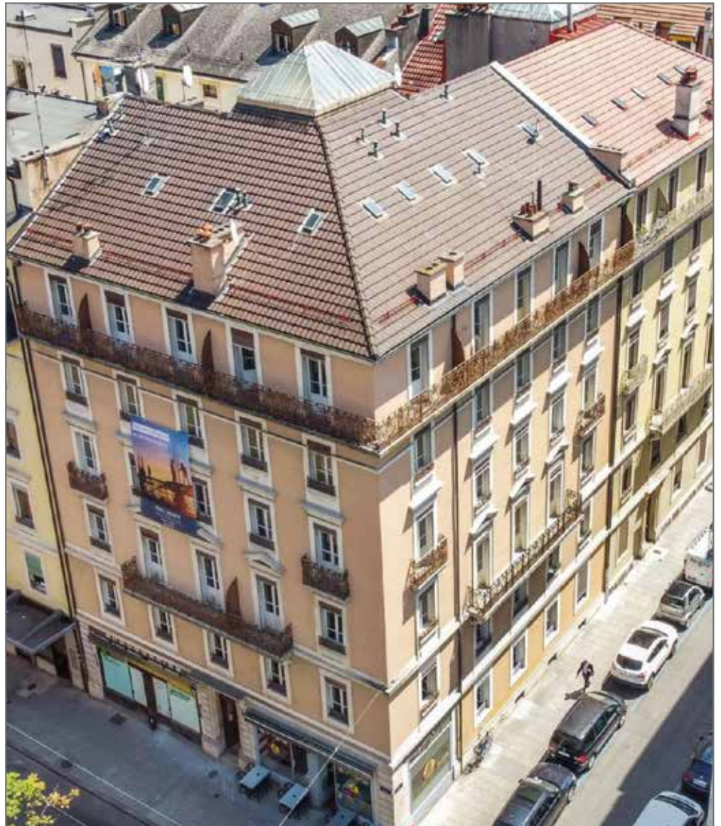
Pour la rénovation d'un immeuble situé au 87 rue de Carouge, la régie Pilet & Renaud s'était fixé un objectif ambitieux: s'atteler à la diminution des émissions de CO 2 durant toutes les phases du chantier et occasionner le moins de déchets possible.
