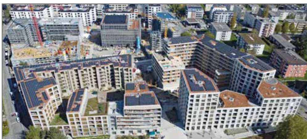
Grâce au contracting déployé par SI-REN dans l'écoquartier des Plaines du Loup, les habitants profitent de l'énergie solaire produite sur le toit de leurs immeubles.
