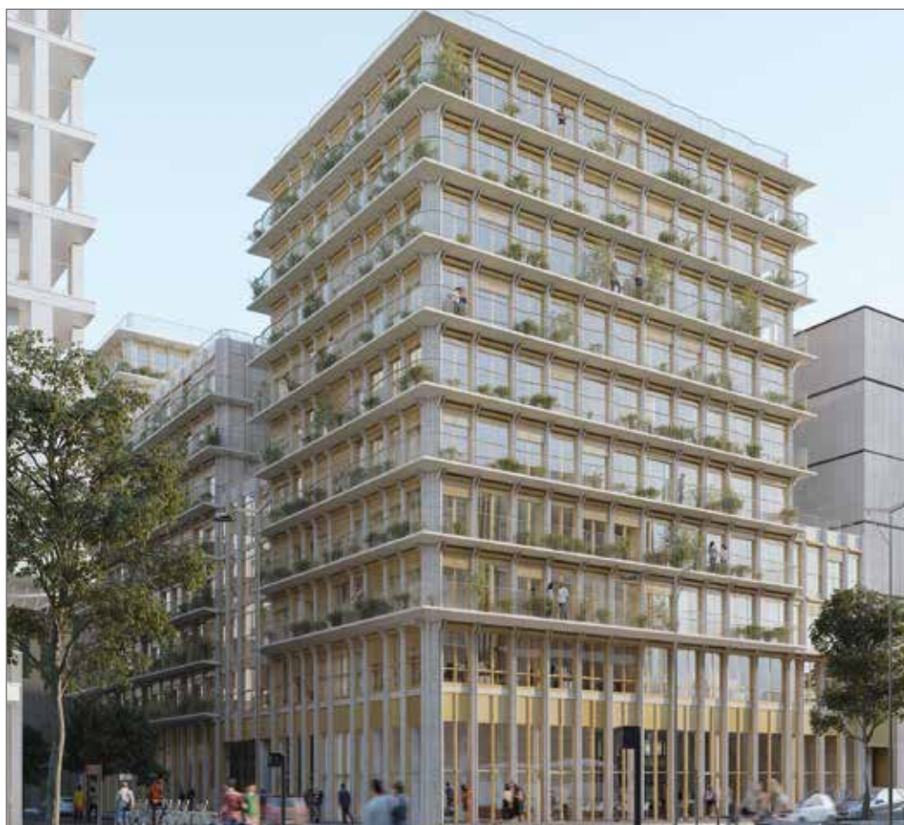
Immeuble parisien conçu comme une grande charpente élevée au-dessus d'un faisceau ferroviaire.
