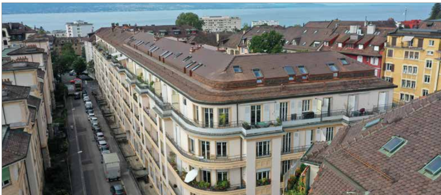
Surélévation d'un immeuble classé des années 1930, avenue de Floréal 12-14 et rue Voltaire 7, à Lausanne.
