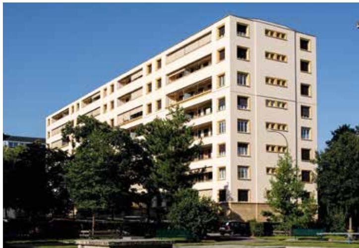
A la Rue Guye 1-7 à Genève, Realstone a couplé des travaux de rénovation énergétique avec une surélévation de 2 étages, permettant de créer 10 appartements supplémentaires.
