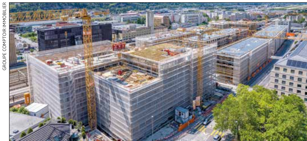
La fin des travaux est prévue pour l'automne 2024.
