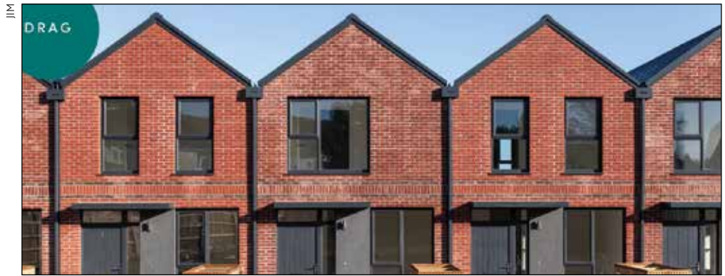
Entièrement conçues en usine, les maisons TopHat sont installées en moins de six mois.
