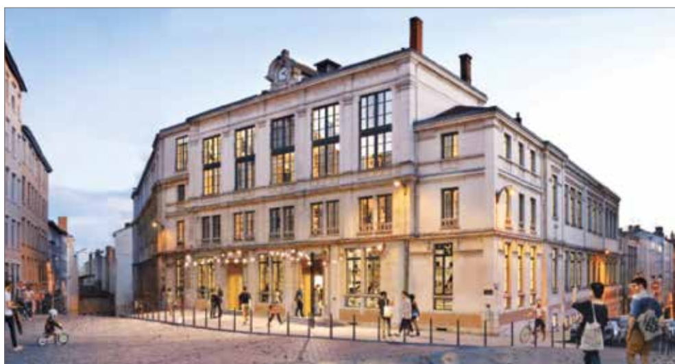
Lors de la réhabilitation par Linkcity du Collège Truffaut (Lyon) en un lieu de vie multi-usages dédié à la jeunesse, de nombreux matériaux ont été réemployés in situ et sur d'autres projets.
