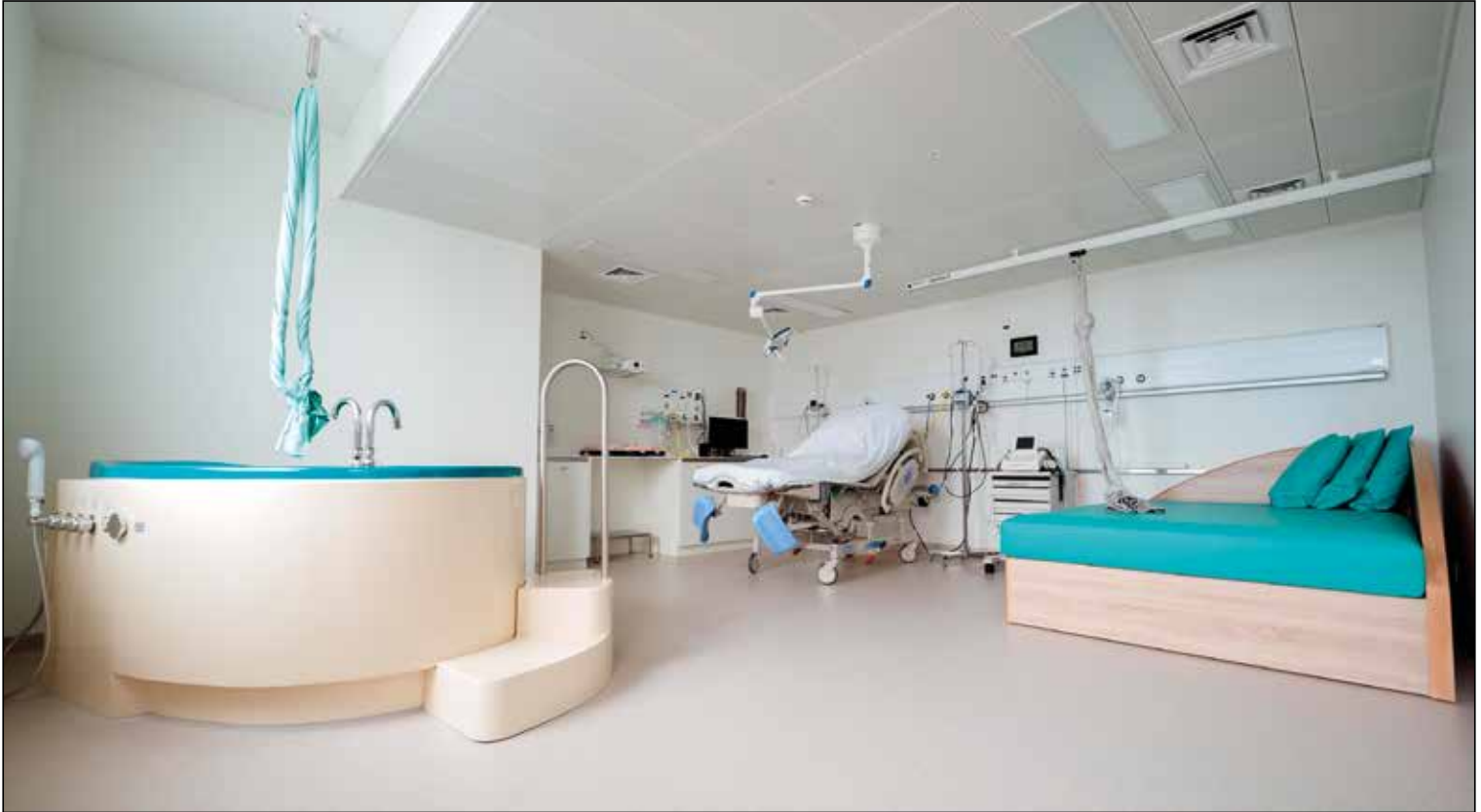
L'extension/transformation de l'Hôpital de Nyon impliquait de nombreuses difficultés techniques.
