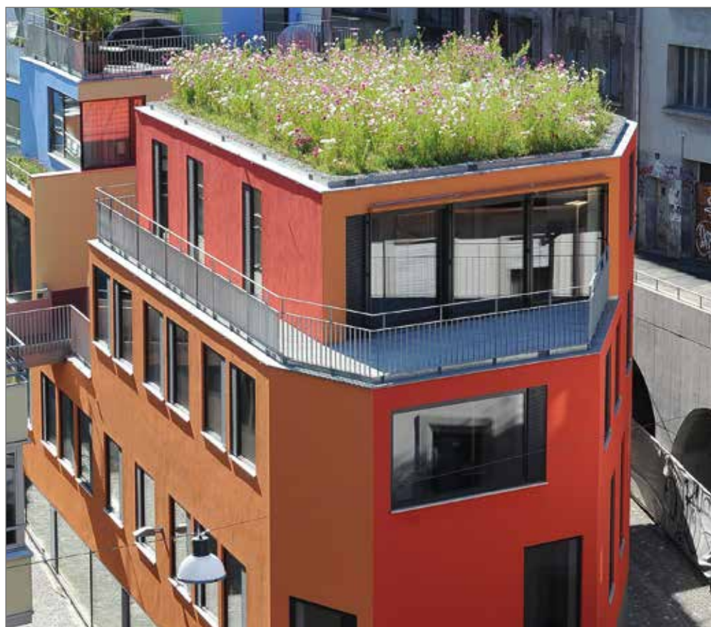
Immeuble de la régie Galland, à la rue du Flon.
