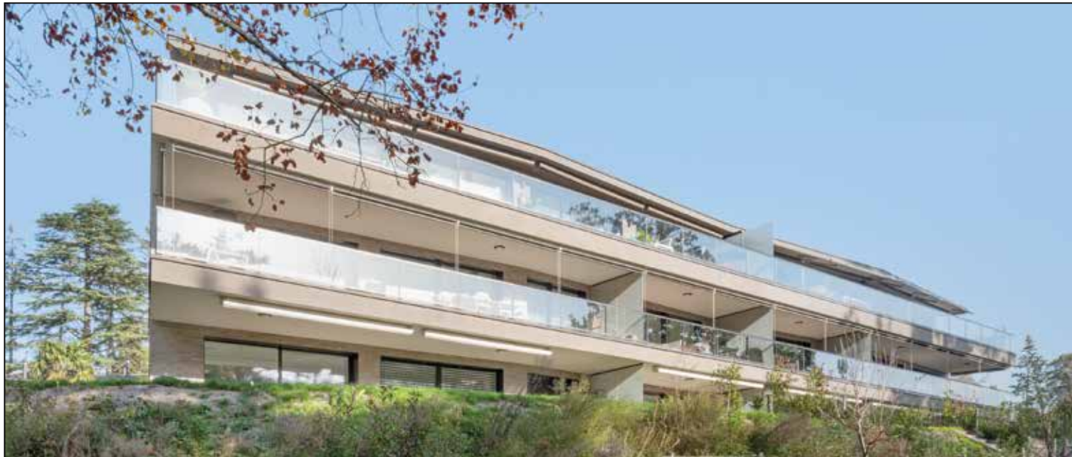
Les appartements - aux prestations élevées et finitions raffinées - bénéficient de vastes balcons et terrasses.
