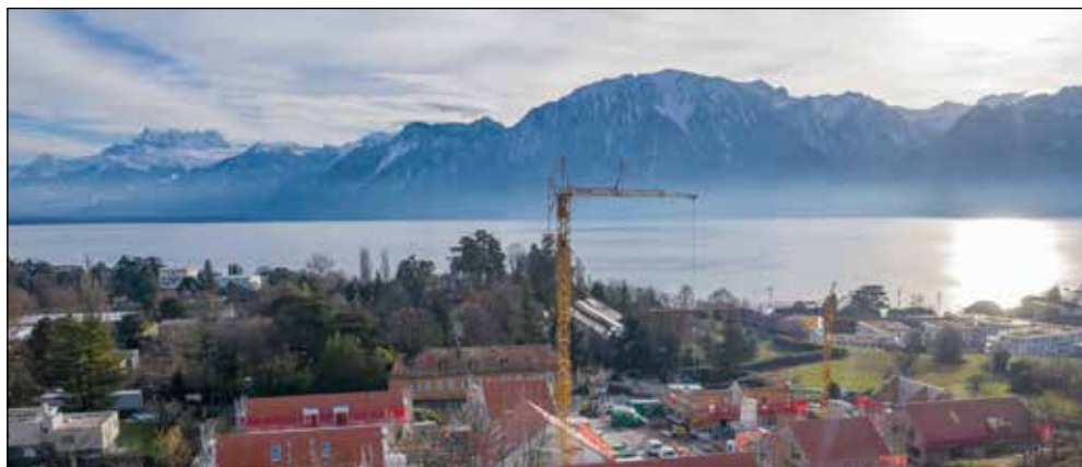
Exemple d'un projet de développement immobilier financé par les investisseurs de Foxstone: Construction par la société Capvest Advisors SA de 20 villas à la Tour-de-Peilz (VD).
