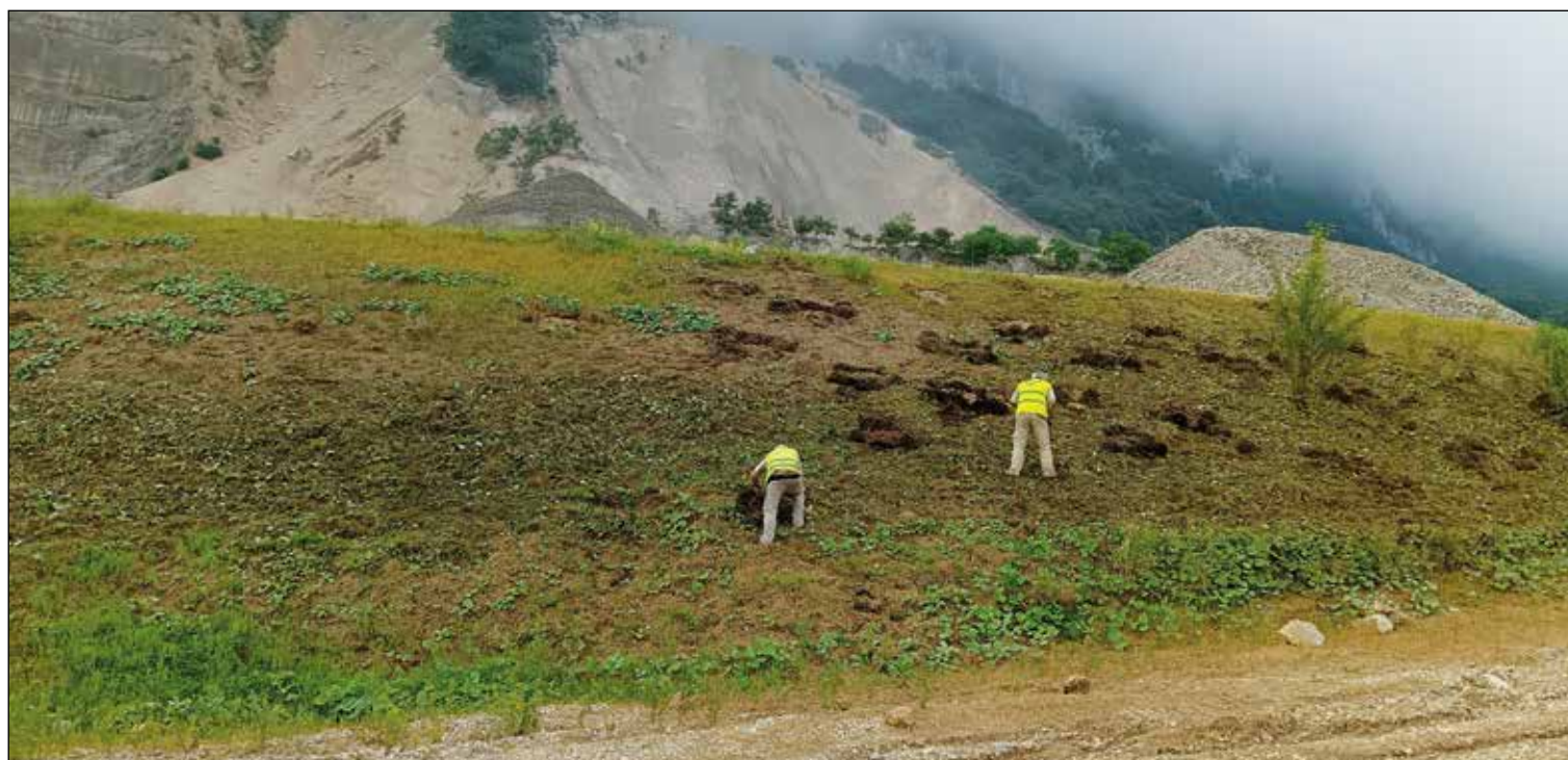
Opération de renaturation du Salève en cours.
