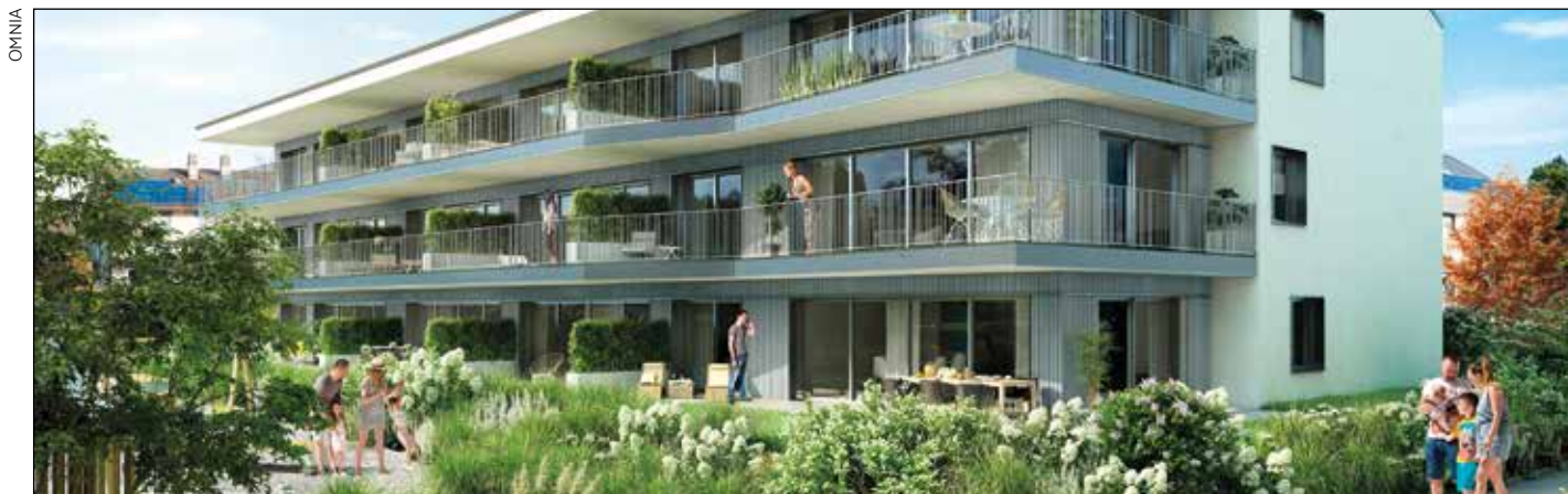
Soixante-sept appartements sont sur le point d'être livrés à Echandens (Vaud).
