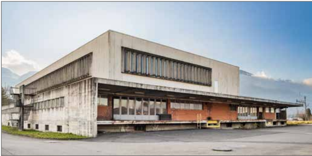
Avant les travaux: un bâtiment qui tombait en décrépitude!
