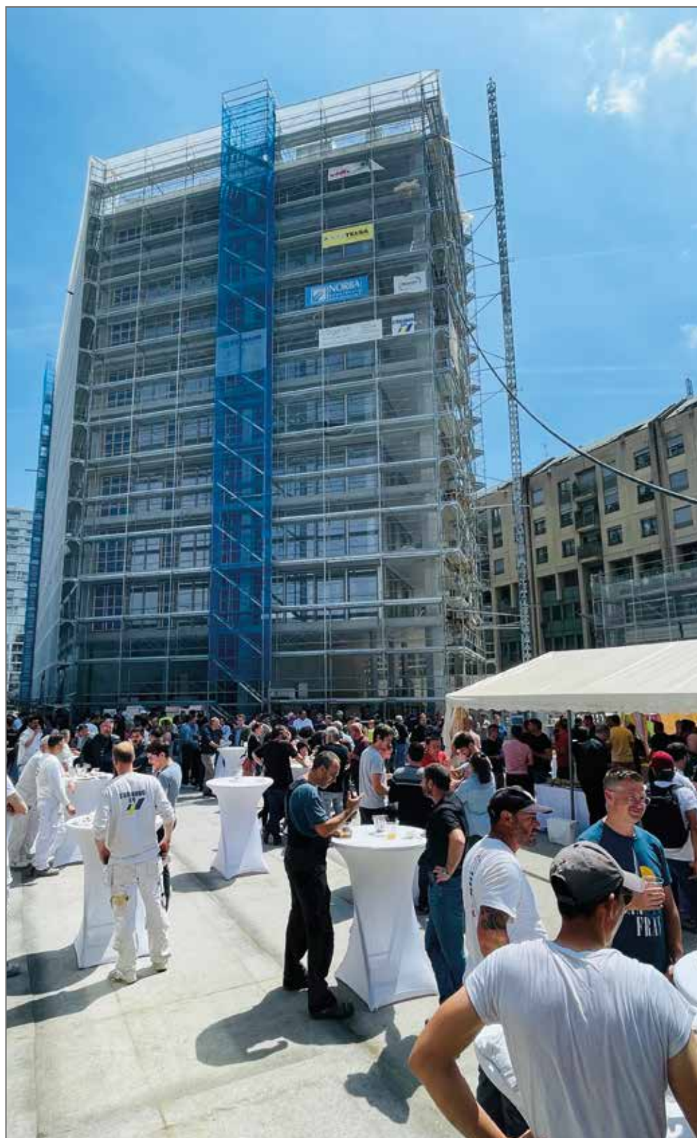
Un bouquet de chantier qui a pérennisé une tradition: des enveloppes pour les ouvriers et un savoureux repas offert aux personnes présentes.
