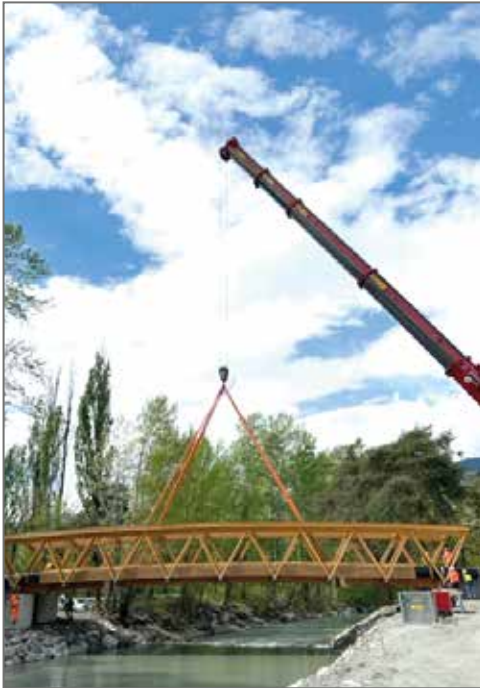
Une grue de 50 tonnes.
