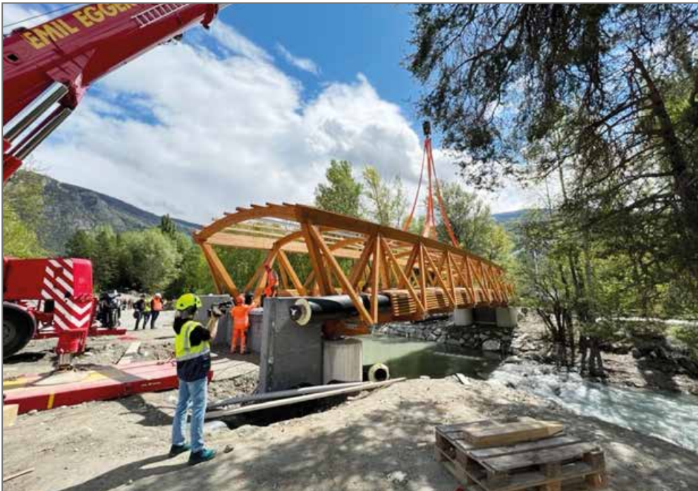
Pose de la passerelle.
