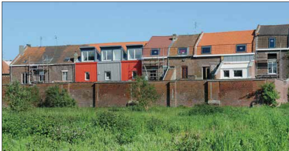
Maisons ouvrières à Tourcoing réhabilitées avec les futurs habitants.
